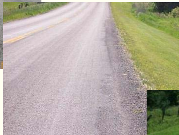
Edge Cracks
