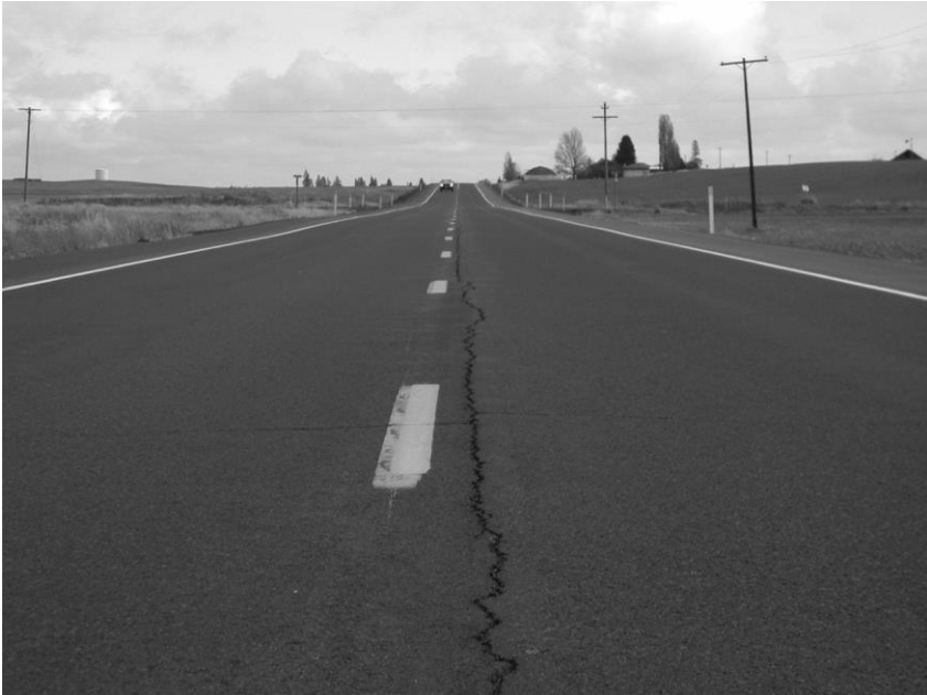
Longitudinal Cracking
