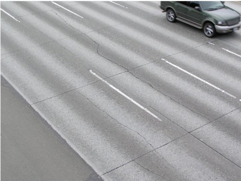
Longitudinal Cracking
